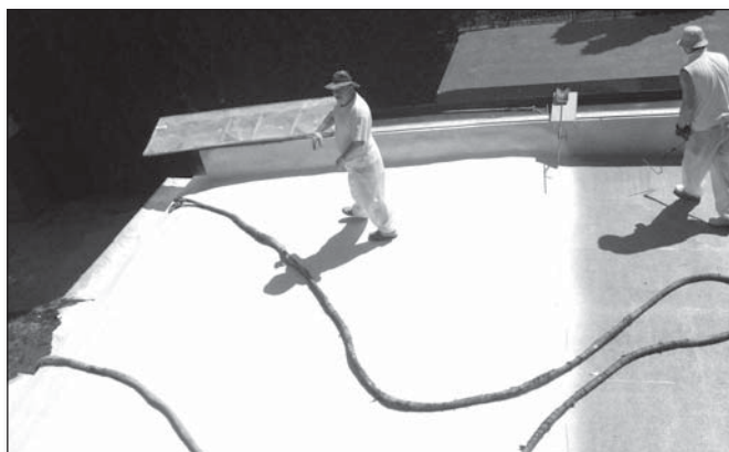
• Strecha je pokrytá izolačnou penou
