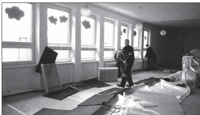
• Staré radiátory boli vymenené za nové
