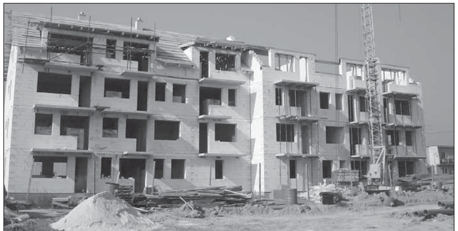
● Rozostavané obecné nájomné byty.
