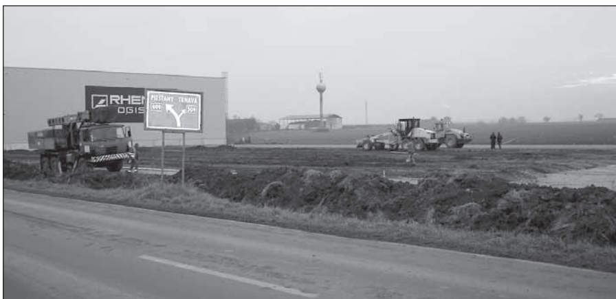
● Začatie výstavby logistického centra spoločnosti Rhénus Logistics v novembri 2010.
