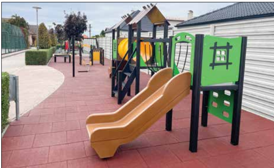
● Bezpečná dopadová plocha, certifikované prvky a bezpečnostné zóny v zmysle platnej STN boli podmienkou rekonštrukcie detského ihriska v Areáli zdravia
