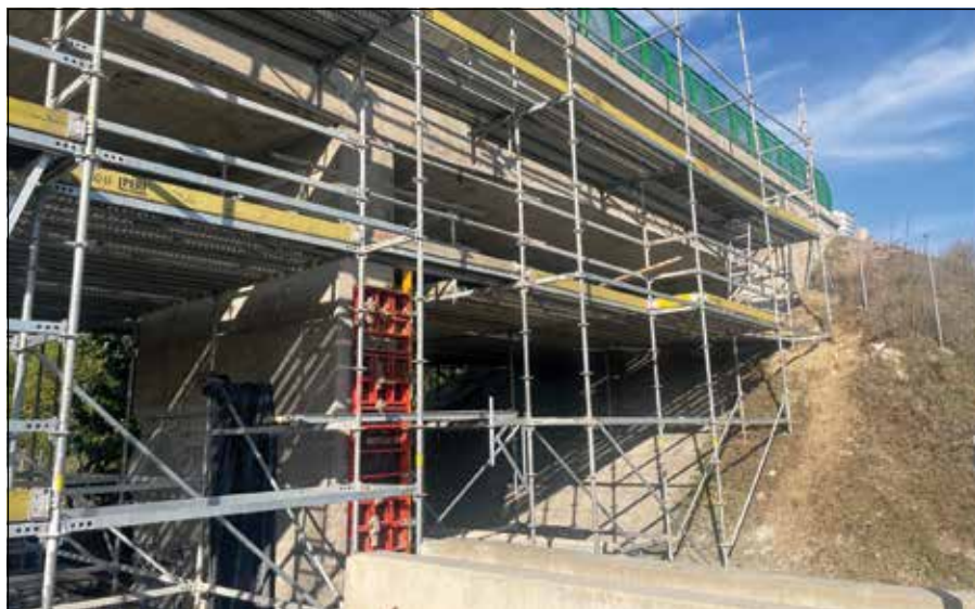
● Oprava mostu nad diaľnicou v rámci stavby CykZC dala zhotoviteľovi poriadne za-brat', realizovala sa na tri etapy a za čiastočnej uzávery diaľnice
