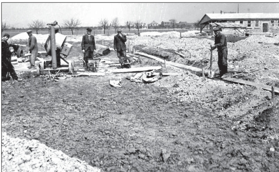
● Rok 1958 – výstavba prvých hospodárskych budov
