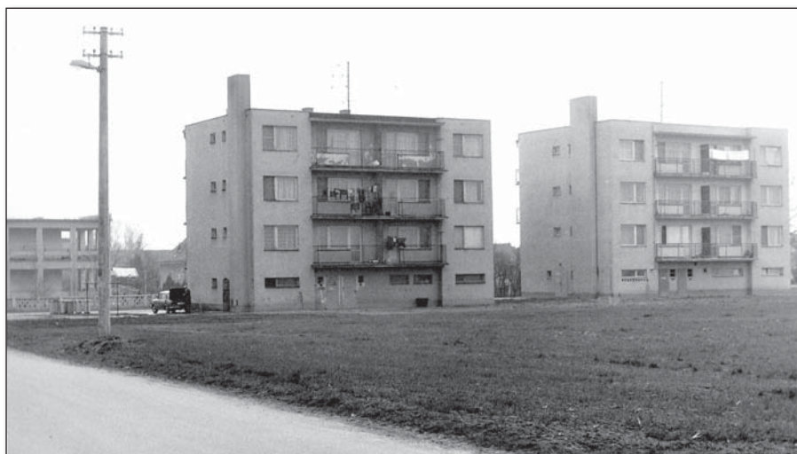
● Bytové domy na Štúrovej ulici postavené družstvom pre svojich zamestnancov
