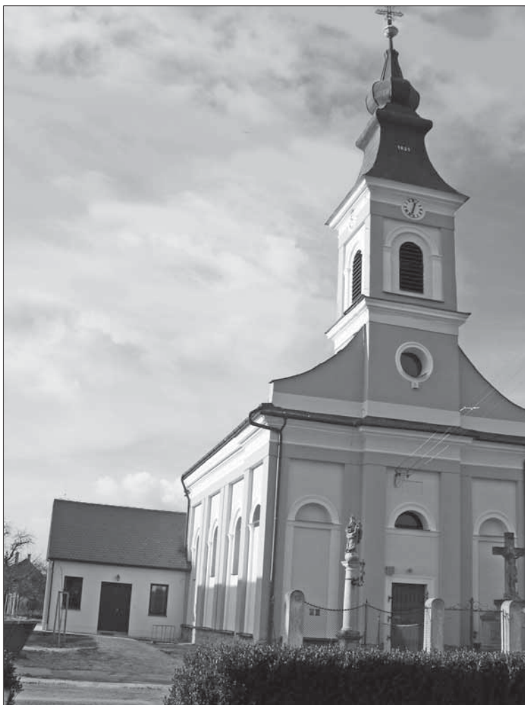
■ Trebatický Kostol sv. Štefana po rekonštrukcii.
