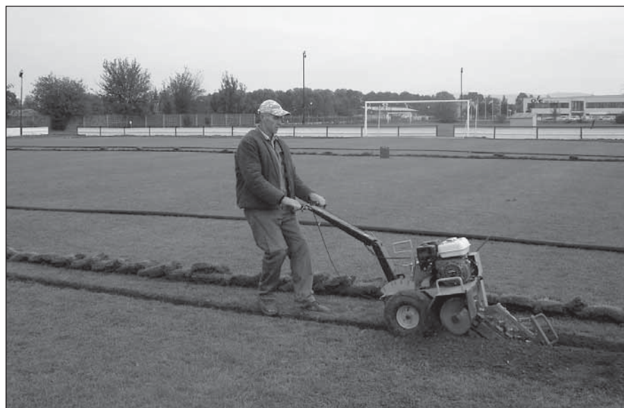
● Jaroslav Radošínský pri hĺbení ryhy automatického zavlažovacieho systému na ihrisku OFK.
