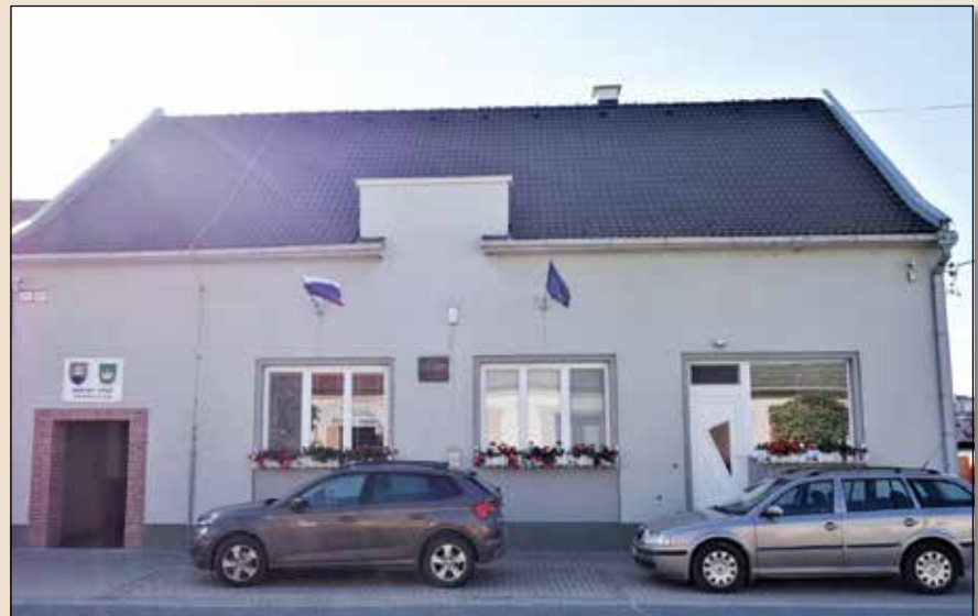
● Obecný úrad Trebatice dostal v rámci rekonštrukcie novú fasádu
