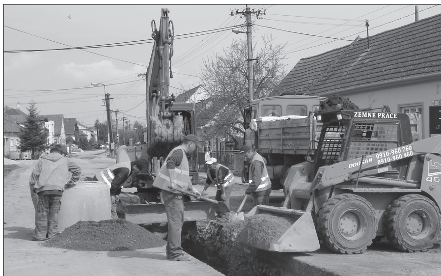
● Budovanie dažďovej kanalizácie.
