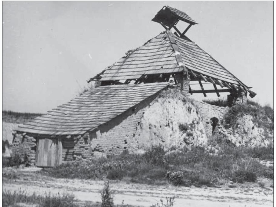
● Bývalá tehelňa v obci Trebatice - časť vypaľovacej pece.
