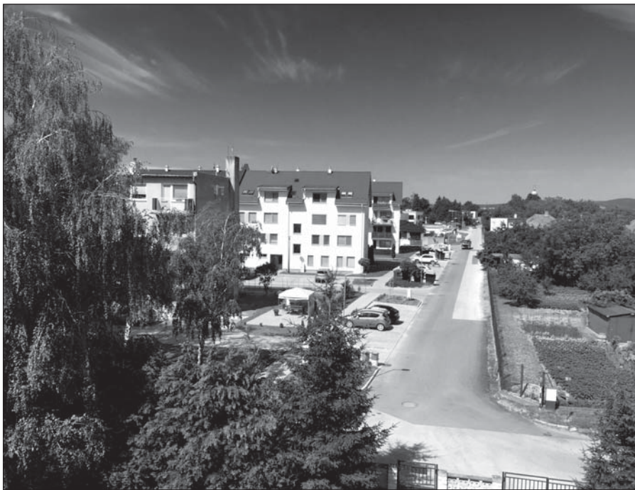
● Zrekonštruovaná časť Družstevnej ulice
