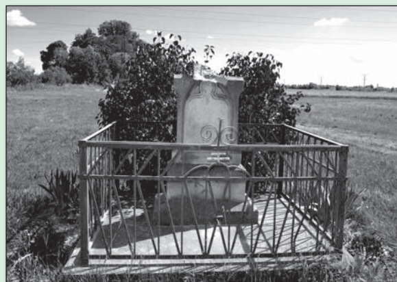
● Podstavec kríža pred jeho obnovou
