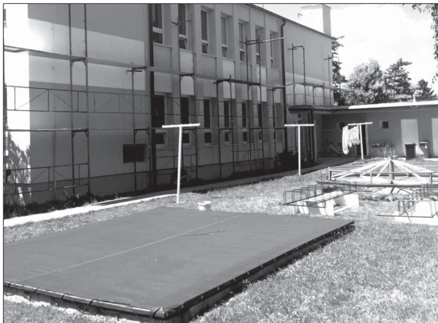
• Obnova materskej školy krátko pred dokončením
