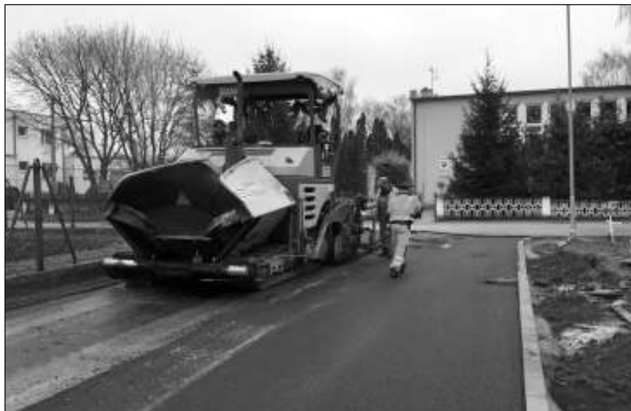
• Rekonštrukcia Družstevnej ulice
