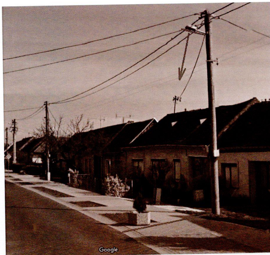
Obr. 5 Veľká vzdialenosť od osvetľovanej komunikácie a nevhodná dĺžka výložníka
